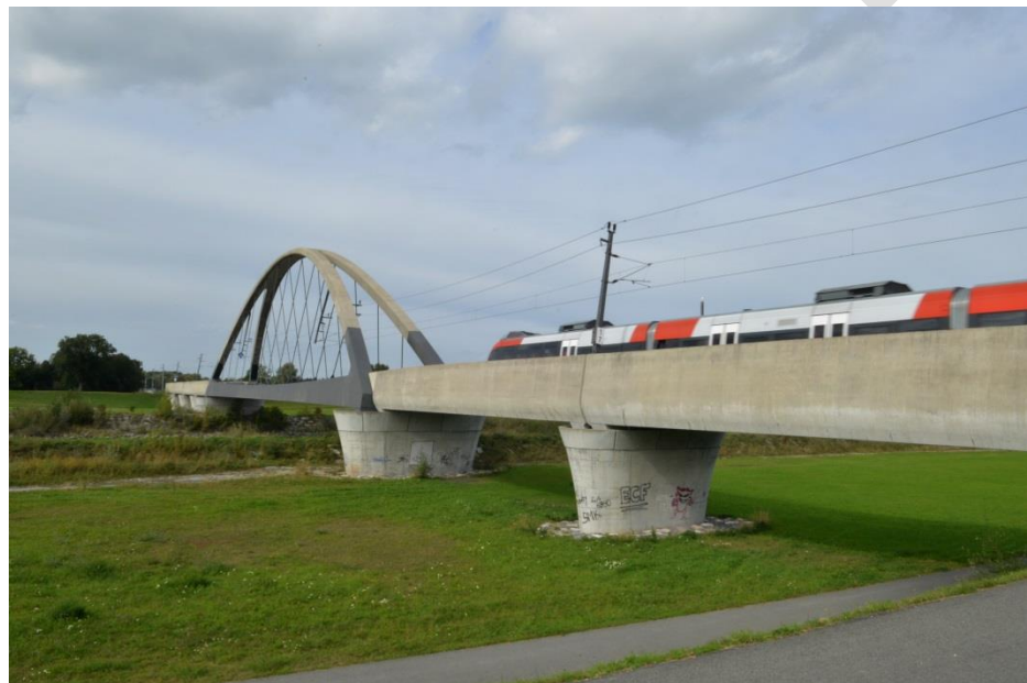
Abbildung 1-2: Die neue Rheinbahnbrücke zwischen Lustenau und St. Margrethen
